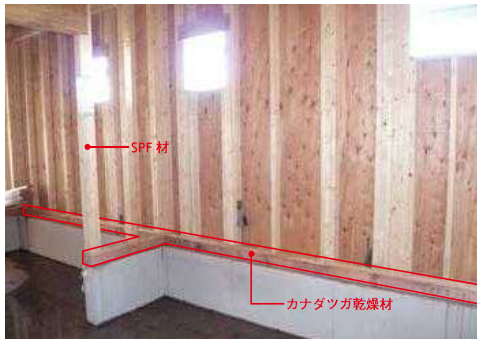
主要構造部にはカナダ産の汎用的な木材が使用されている。土台にはカナダツガ乾燥材、柱にはSPF材がそれぞれ採用された
