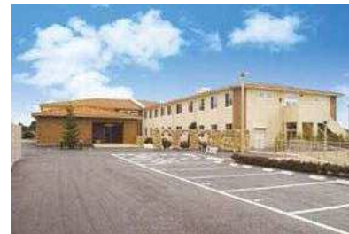
外観のデザインは、介護施設のイメージを一新させる南欧風とした。外装は窯業系サイディングで仕上げている
