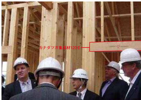
ブリティッシュコロンビア州の閣僚一行による視察の様子。居室の入口のまぐさには、上部荷重をしっかりと支えられる90×140mmのカナダツガ集成材120Eを採用した
