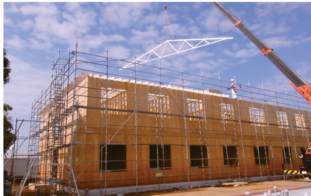
2×4工法による大型耐火建築の有料老人ホーム。工場加工の屋根トラスで施工効率が上がった
