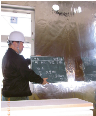
耐火検査（写真左）とアルミ箔の工事現場の様子。耐火認定の検査項目は非常に多く、その認定に基づき何度も検査が行なわれる。下貼り石膏ボード15mmの上にアルミ箔が貼られ、その上に21mmの強化石膏ボードが貼られる（写真右）
