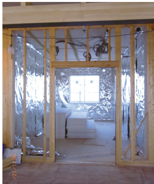
耐火検査（写真左）とアルミ箔の工事現場の様子。耐火認定の検査項目は非常に多く、その認定に基づき何度も検査が行なわれる。下貼り石膏ボード15mmの上にアルミ箔が貼られ、その上に21mmの強化石膏ボードが貼られる（写真右）
