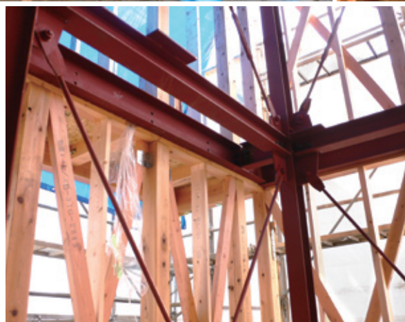
エレベーターシャフトはフレームを鉄骨で構成
