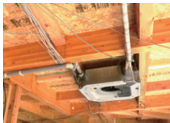
木造の梁を避けて 設備を取り付ける
