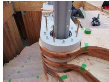
図 3.6 CLT 階段接合部
