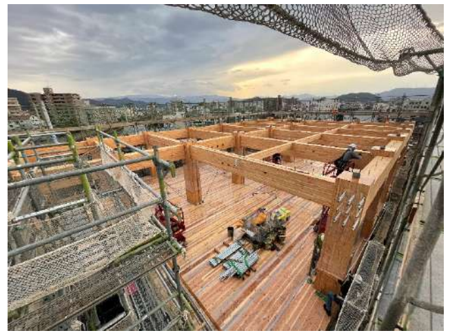
木構造躯体建方状況
