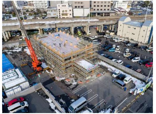
2 層目 (3 階床) 建方状況
