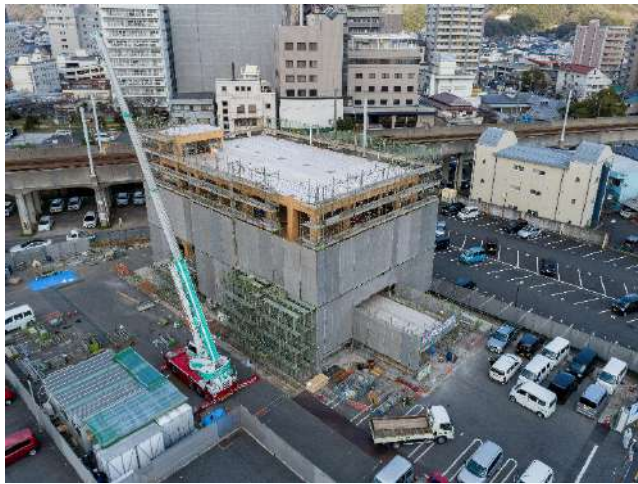
木構造躯体建方完了
