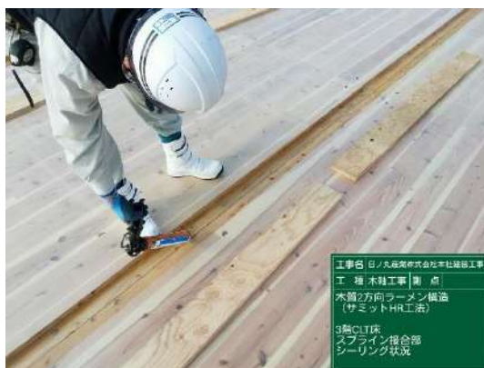
写真6 スプライン接合部処理状況
