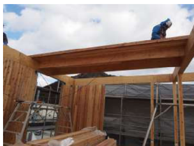
図 3.3 リブ付 CLT パネル施工
