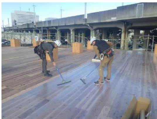
写真 1 養生シート張り状況
