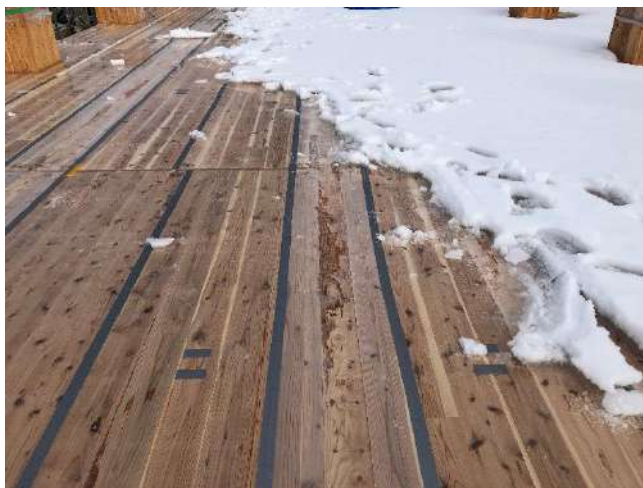
写真 降雪後の状況 除雪によるシートの捲れはない
