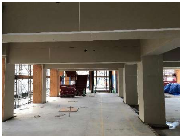
写真 下層階より耐火被覆工事を実施
