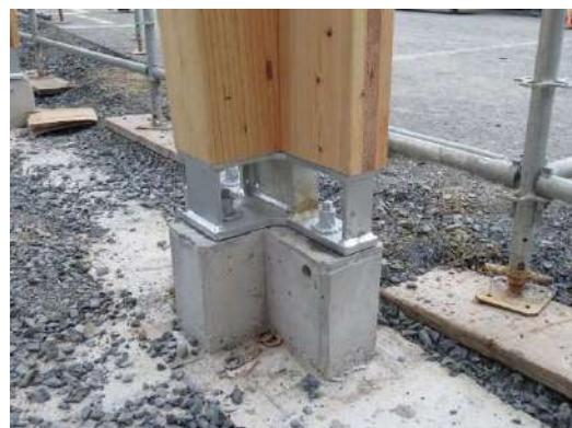
写真12：パーゴラ部柱脚金物
