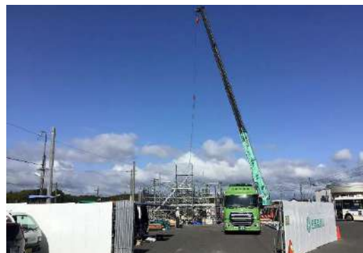
写真 17 : CLT パネル建方状況
