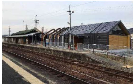
写真1：隣り合う新旧の駅舎
