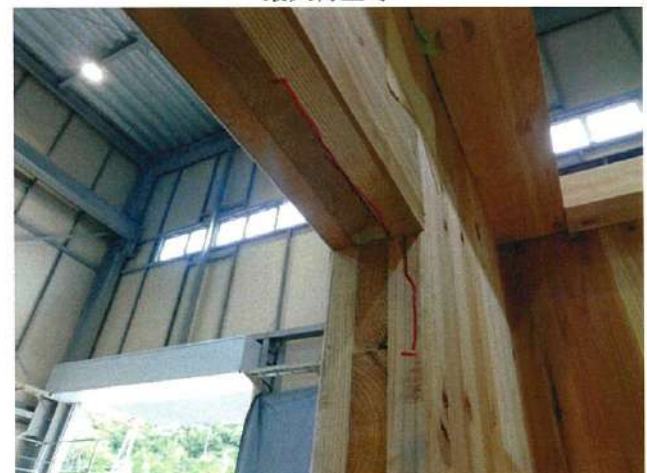
写真7 試験体の状況 試験体：ユニット 最大荷重時
