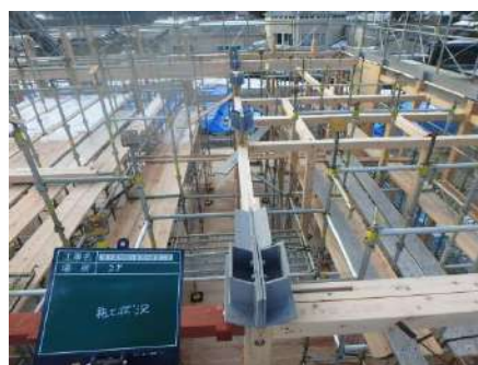
屋根 CLT 受金物取付
