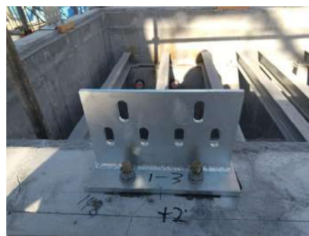
図 1.5 CLT 柱脚せん断金物
