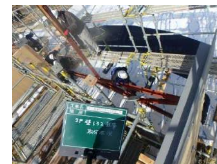
鉄骨トラス取付
