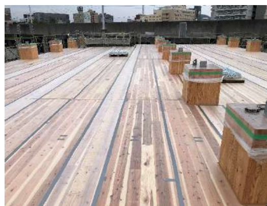
2層目（3階床）養生状況
