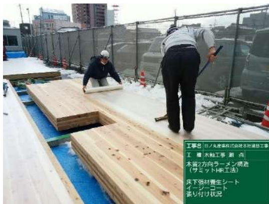
写真4 CLT 設置前のシート張り状況
