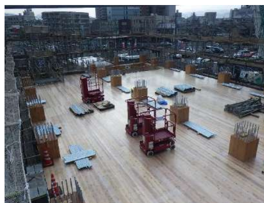
養生実施後の作業状況
