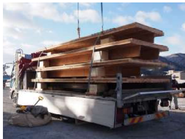
図 3.1 リブ付 CLT パネル搬入
