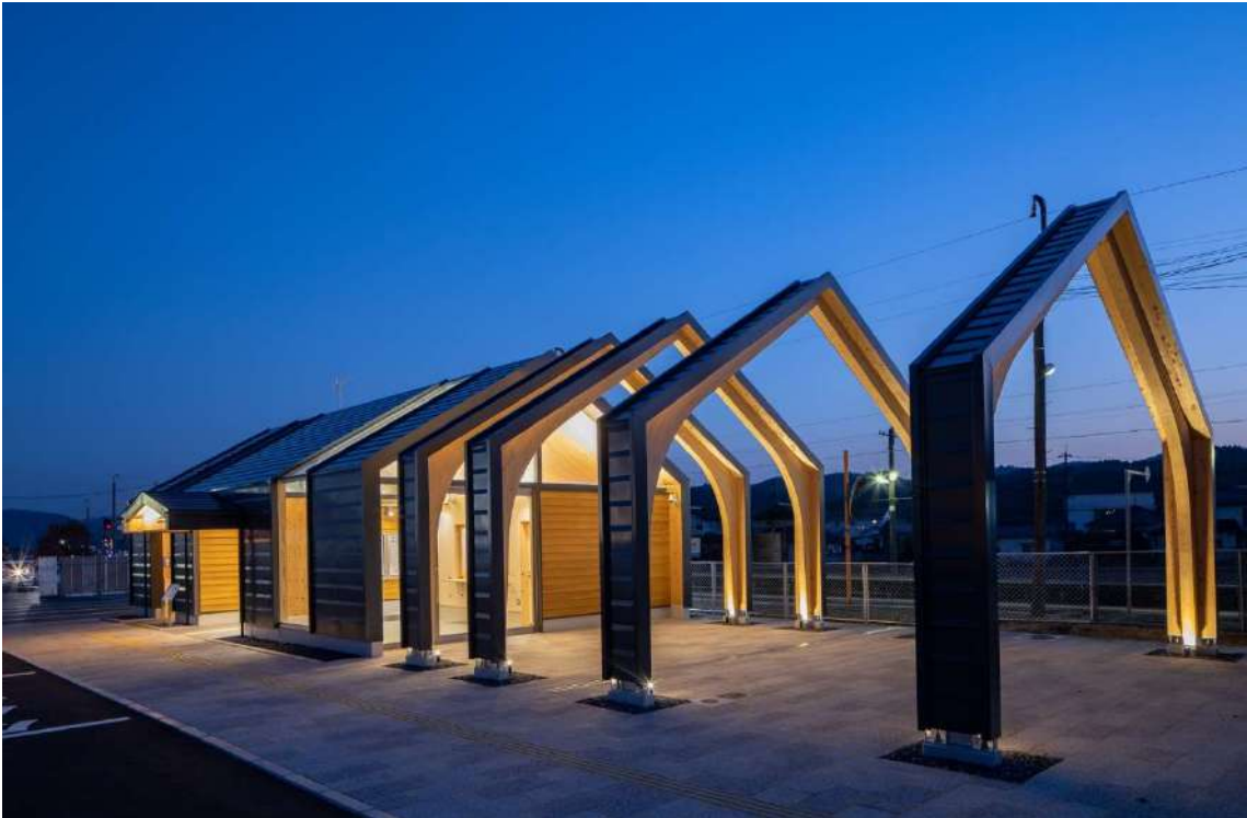
竣工写真 7：外観（夜景）
