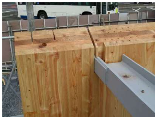
写真8：タイバーと壁パネル
