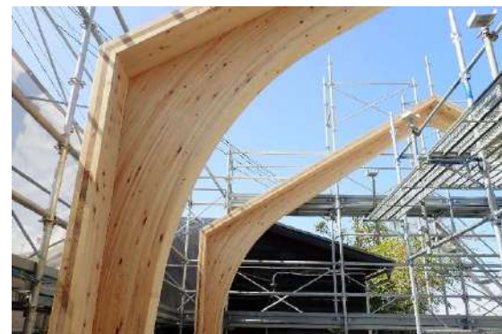
写真4：門型フレーム（パーゴラ部分）
