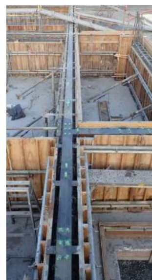
図 1.3 アンカーテンプレート
