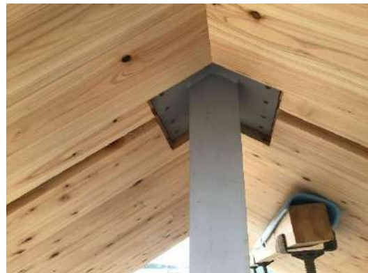
写真15: CLTガラス枠とポスト柱上部
