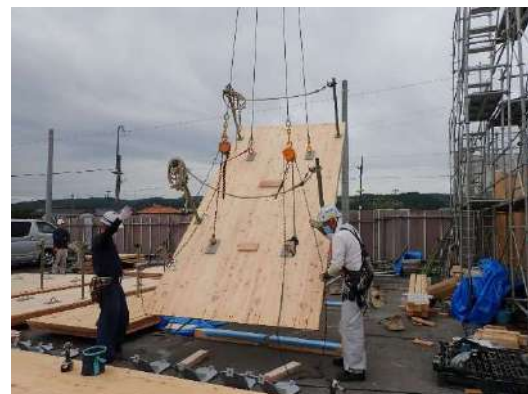
写真16: CLTパネル仮設ピース
