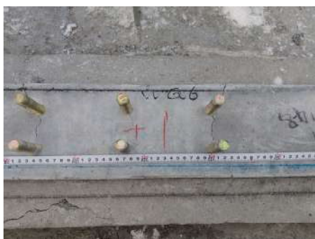
図 1.4 アンカーボルト位置の測定
