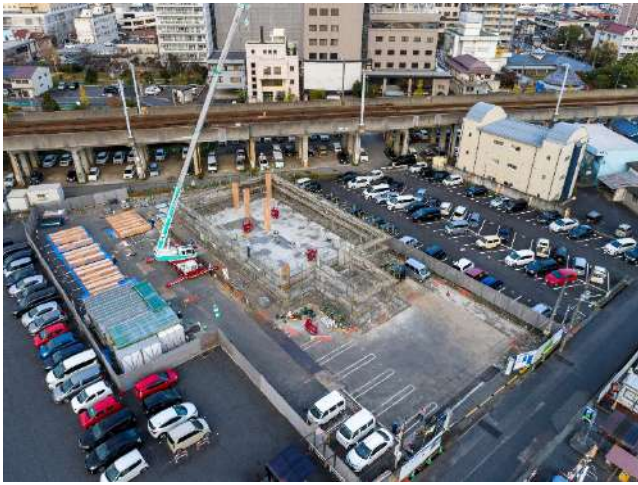
1 層目 (1 階柱) 建方状況
