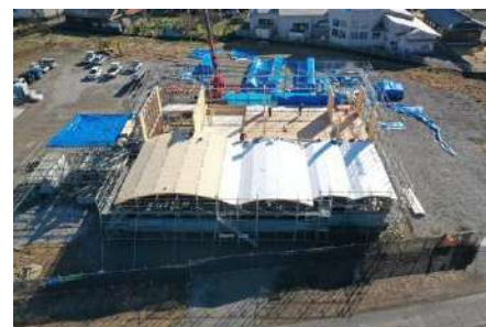
屋根 CLT 取付
