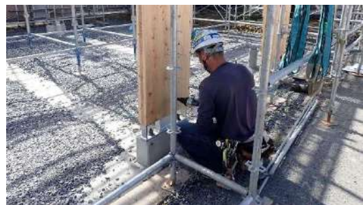
写真7：CLT 建方状況（パーゴラ部分）
