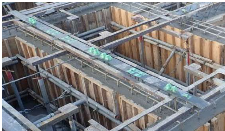
図 1.2 アンカーテンプレート
