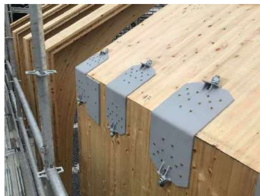
写真9：壁一屋根パネル接合部金物
