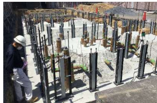
写真5：アンカーフレームセット状況
