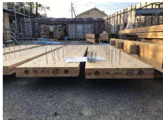
写真11：集成材フレームと接合する CLT パネル
