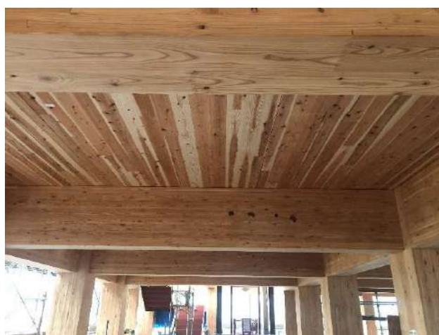
写真左 CLT 養生面には降雨により水が滞留しているが、下層への漏水は確認出来ない。写真右
