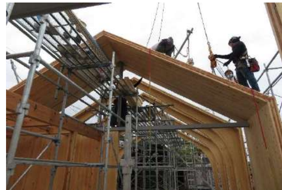
写真3：門型フレーム（駅舎部分）
