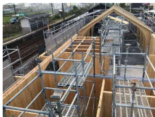
写真 19 : 建方完了時に外壁を構成できる
