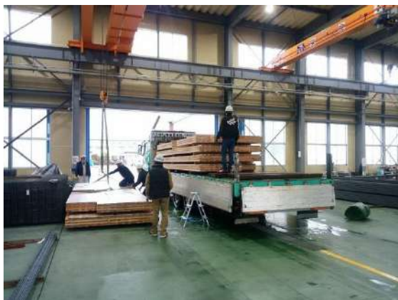
写真 CLT 仮搬入状況
