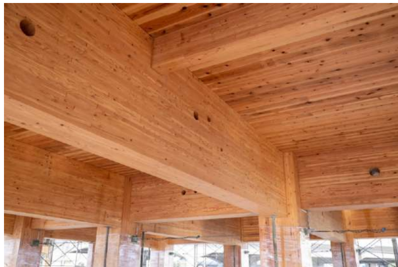
木構造躯体内部
