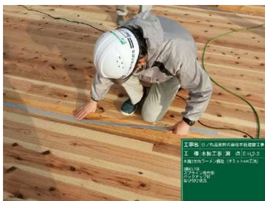
写真 3 スプライン接合部処理状況
