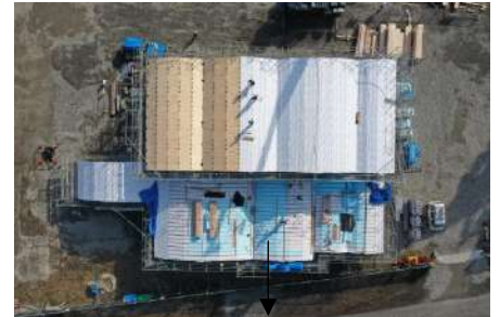
屋根 CLT 取付
