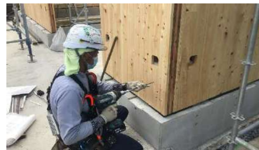
写真6：CLT 建方状況（駅舎部分）
