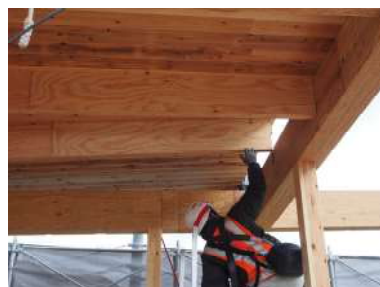
図 3.4 リブ付 CLT パネル施工
