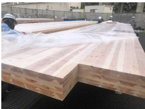
写真 養生実施後運送用に梱包された CLT
