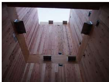
図 3.7 CLT エレベーター昇降路
