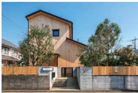
Aiシル®の実装1棟目となった、埼玉県所沢市にある増木工務店のモデルハウス「トコみど」。同社で新築した物件を、施主の転居に伴い賃貸で借り上げ、リノベーションをした上でモデルハウスとして活用している。
